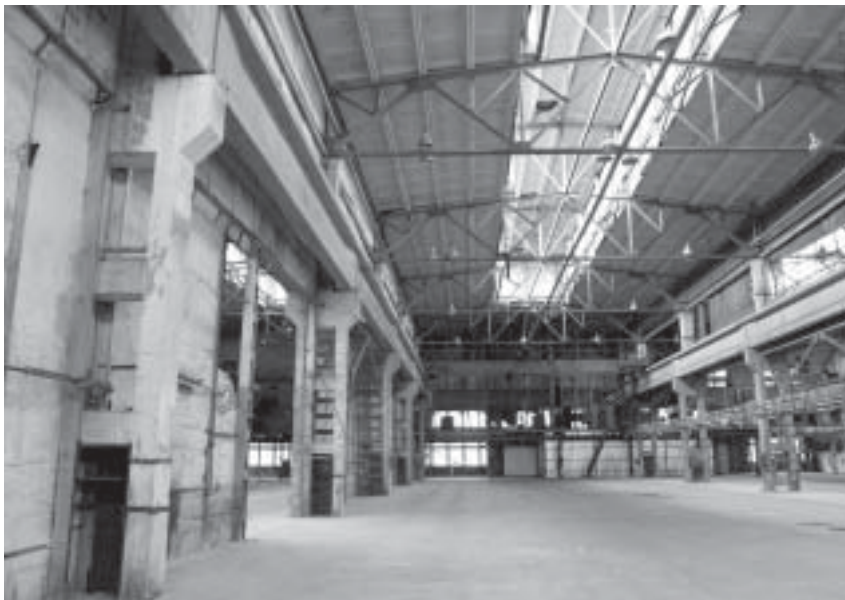
Фибробетонные полы на объединении «Пеноплэкс» (г. Кириши)
