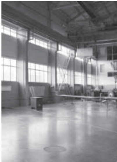
Образец реконструкции полов при помощи сталефибробетона на заводе «Яровит-Моторс» (Санкт-Петербург)
